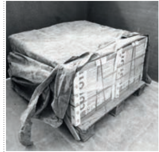
PROTECCIÓN CON PLÁSTICO EN ALMACÉN HASTA LA INSTALACIÓN
